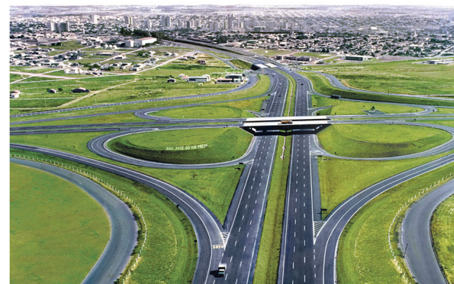
Trevo de ligação SP 425 com BR 153 Concessão de Rodovias
